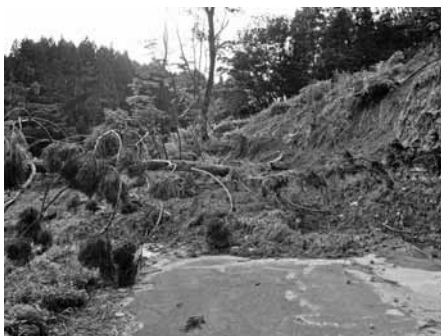
土砂でふさがれた道路（田中地内）
