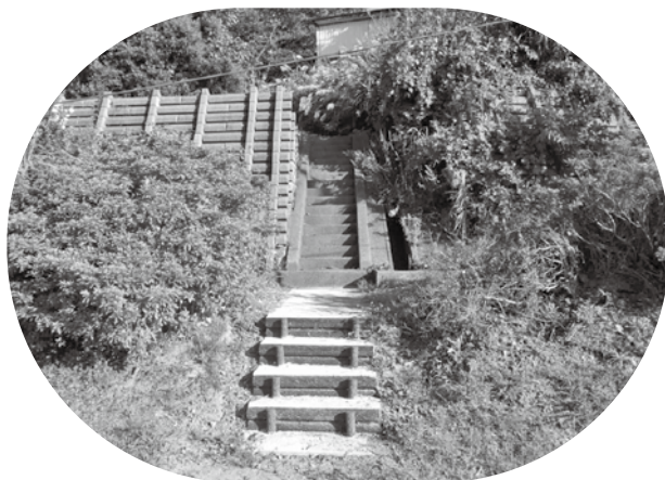
整備した避難通路（尼瀬地内）
