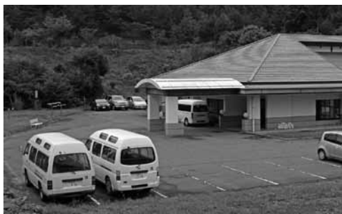
デイサービスセンター 玄関脇に土のうが準備されている
