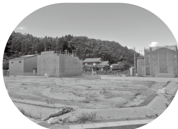
建設中の住宅
