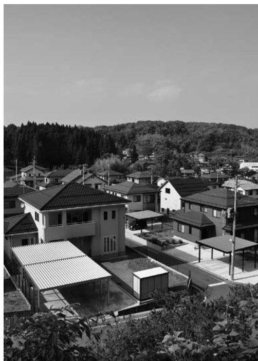
進む宅地造成（てまり団地）
