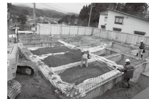
建設中の分遣所
