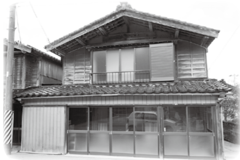
稲荷町の旧津又邸を改修します
