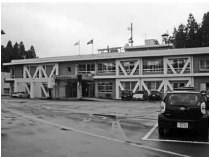
耐震改修済み役場庁舎
