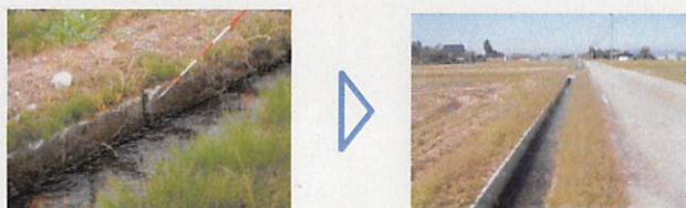
老朽化した水路の整備
