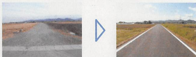
農作業道の整備
