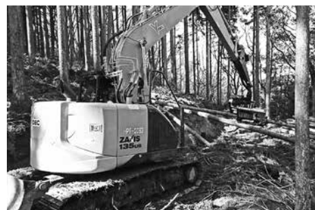
機械化された間伐作業
