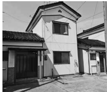
修繕を行う教員住宅（石井町）
