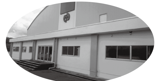
中学校体育館・校舎棟外壁改修工事
