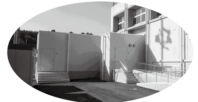
改善センター放射線防護対策工事
