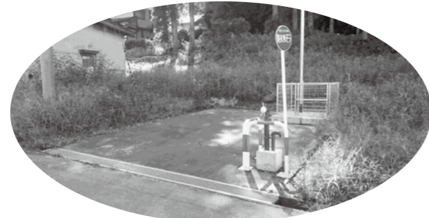
防火水槽設置工事
