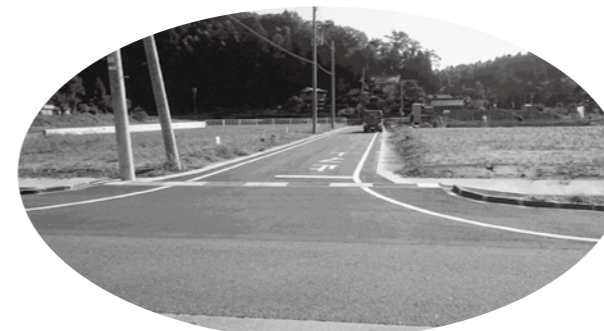
松本南住宅団地造成工事
