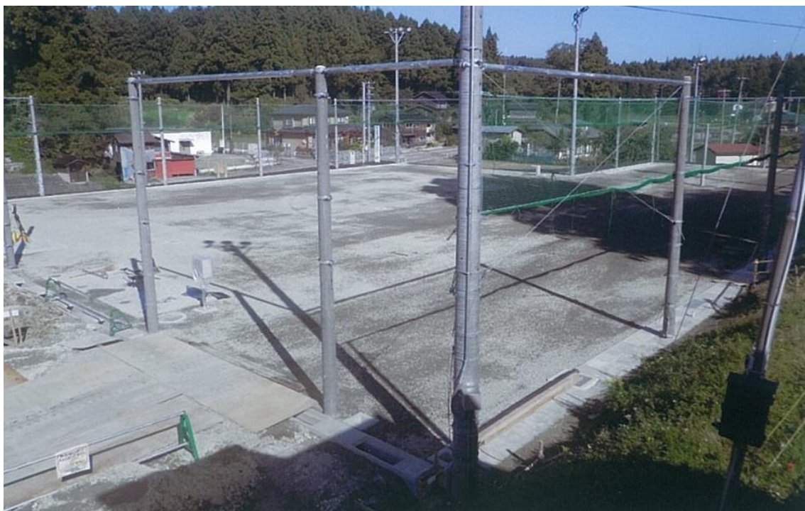
下層路盤 完了
