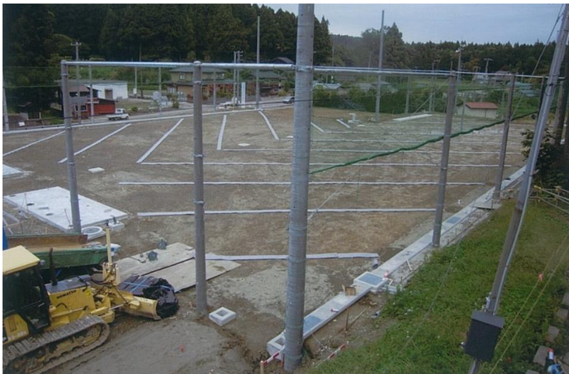
土木工事・排水工事 完了
