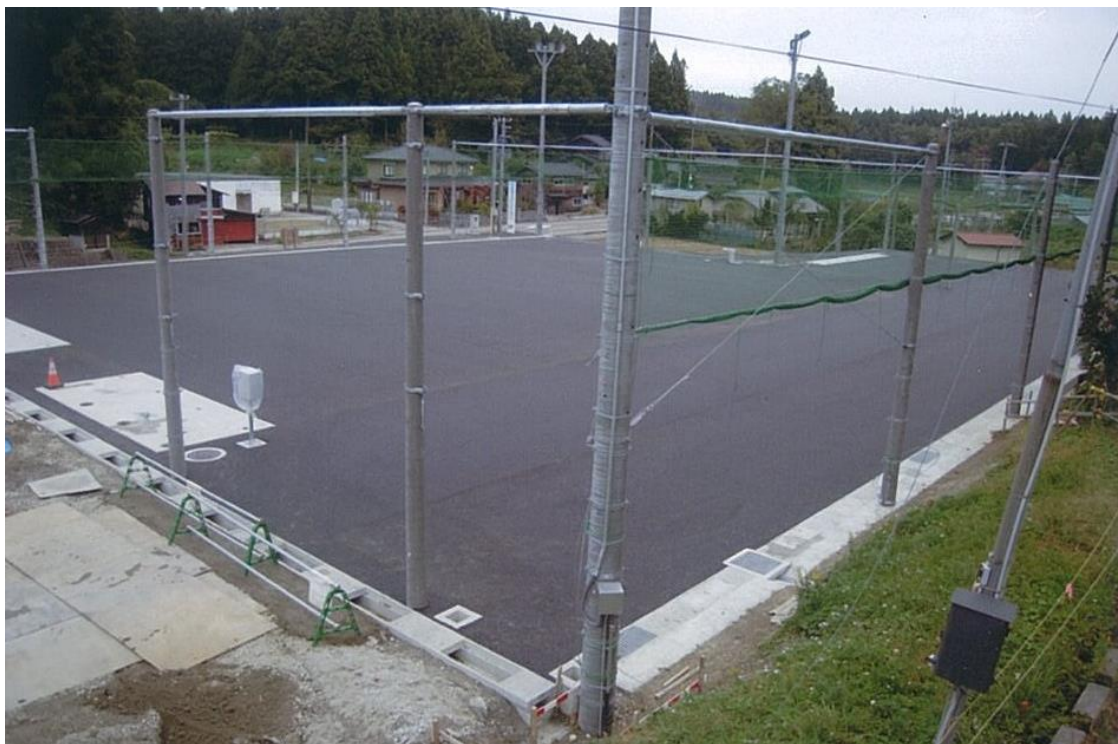
舗装工事 完了
