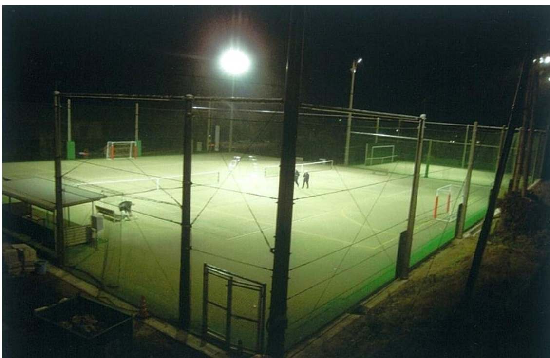
LED照明器具 完了
