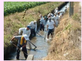
水路の泥上げ
