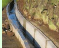
コンクリート水路の更新
