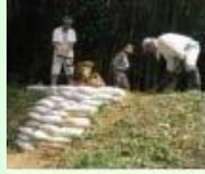
漏水箇所の補修
