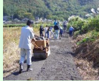
未舗装農道の舗装
