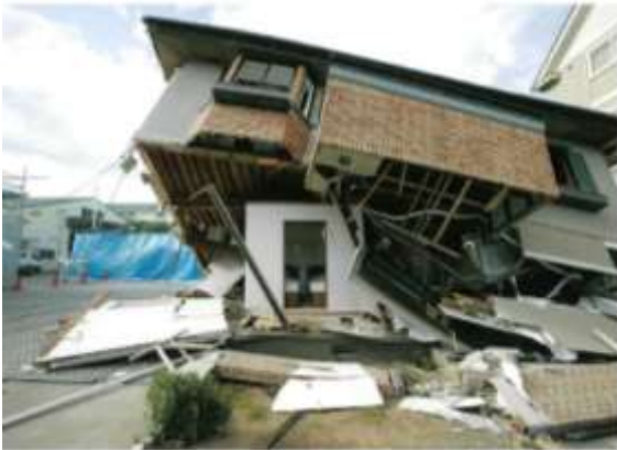
〔耐震シェルターの例〕
